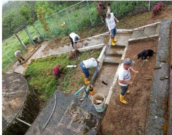
PARTICIPACIÓN DE AUTORIDADES E INSTITUCIONES LOCALES EN LA MINGA DE LIMPIEZA EN LA PLANTA DE AGUA
