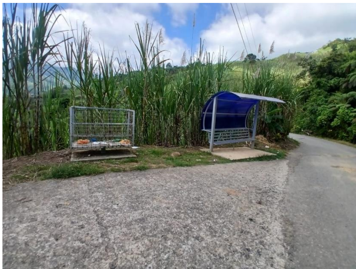
CONSTRUCCIÓN DE CASETAS PARA PARADA DE BUSES Y CONTENEDORES
